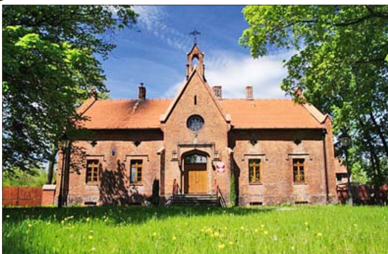
Krankenhaus in Groß Rauden
