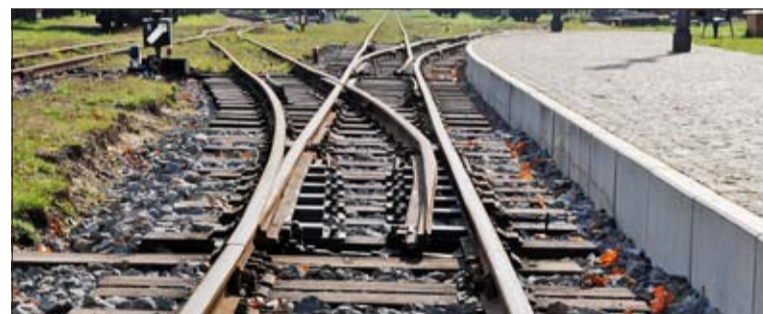
Die Spurbreite in Rauden beträgt 785 Millimeter
