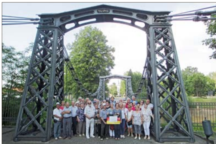
Brücke als Zeitzeuge der Geschichte
